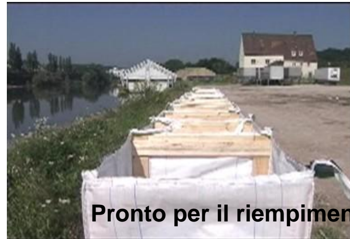
Estensione del sistema alla lunghezza prevista
